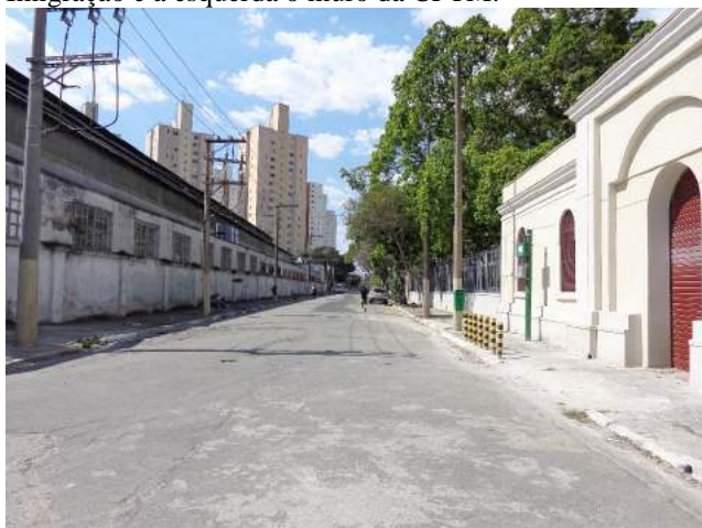
Figura 4: Rua Visconde de Parnaíba, sentido bairro, sendo à direita a entrada principal do Museu da Imigração e a esquerda o muro da CPTM.
